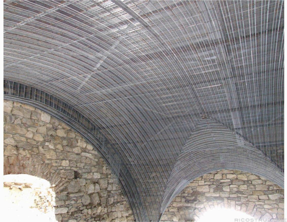
RICOSTRUZIONE VOLTA A VELA
